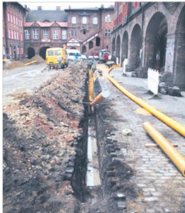
Prace w Nikiszowcu.
